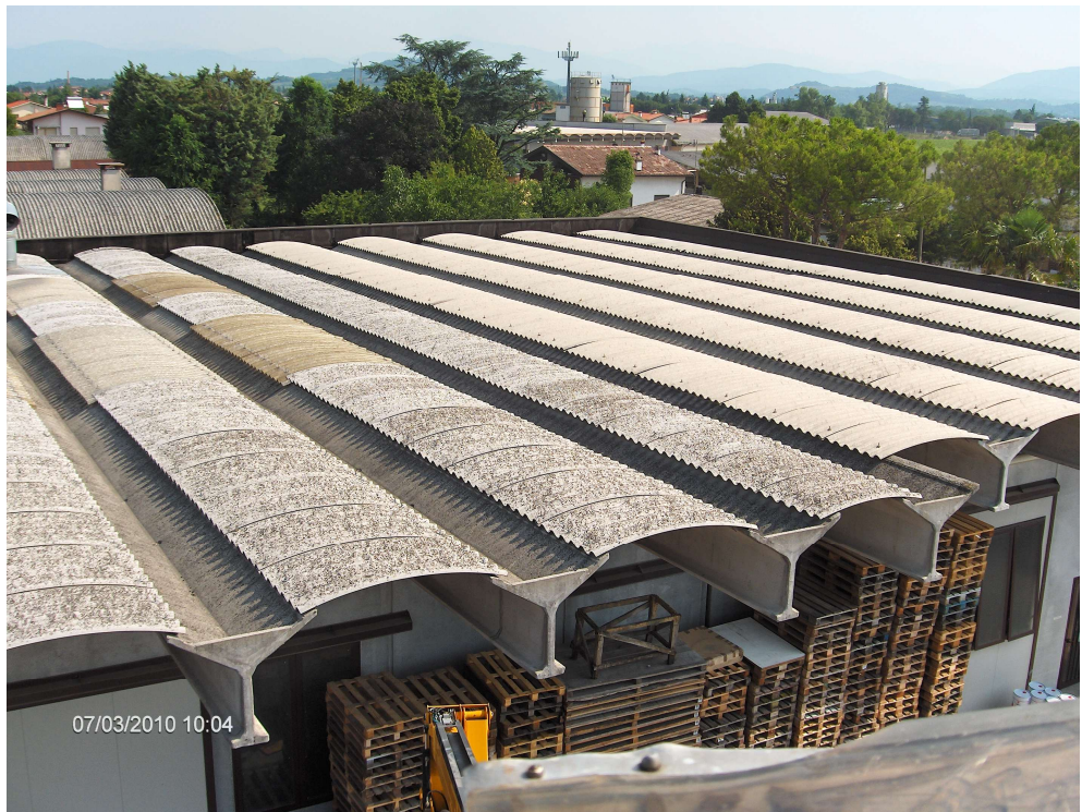
Sostituzione parziale manto di copertura su fabbricato produttivo in provincia di Udine
