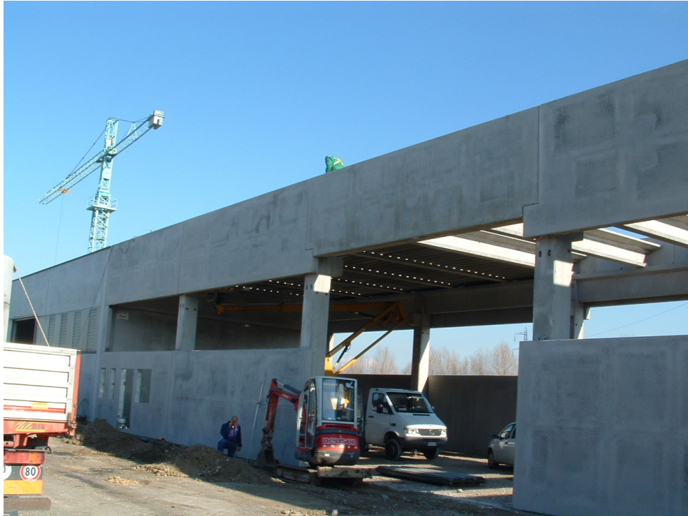
Ampliamento fabbricato produttivo in provincia di Treviso
