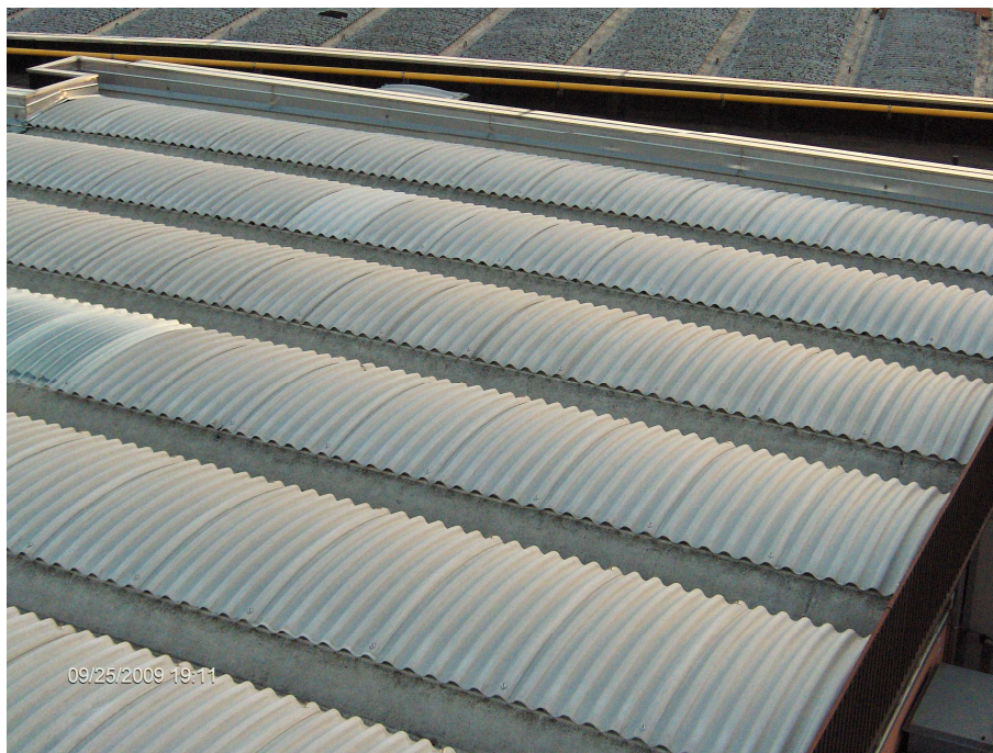
Bonifica eternit e fornitura manto di copertura su fabbricato produttivo in provincia di Vicenza
